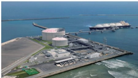
Hitachi LNG Terminal
